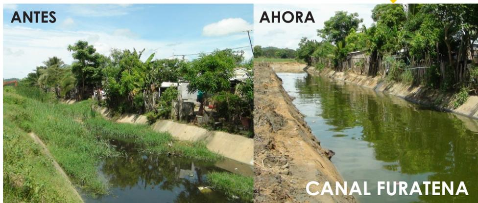
La Alcaldía de Montería ejecuta la limpieza de 27.700 metros lineales de canales en distintos sectores de la ciudad. En la imagen el canal Furatena que atraviesa 7 barrios del sur. En este semestre se realizará el revestimiento en concreto del canal Mocarí, calle 44 y se intervendrán los canales de drenaje de la Granja, Santander y San Martín, entre otros.
